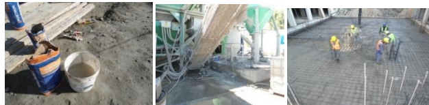
Figure 2.2.1.1: a); b);c);d) Concrete production site
