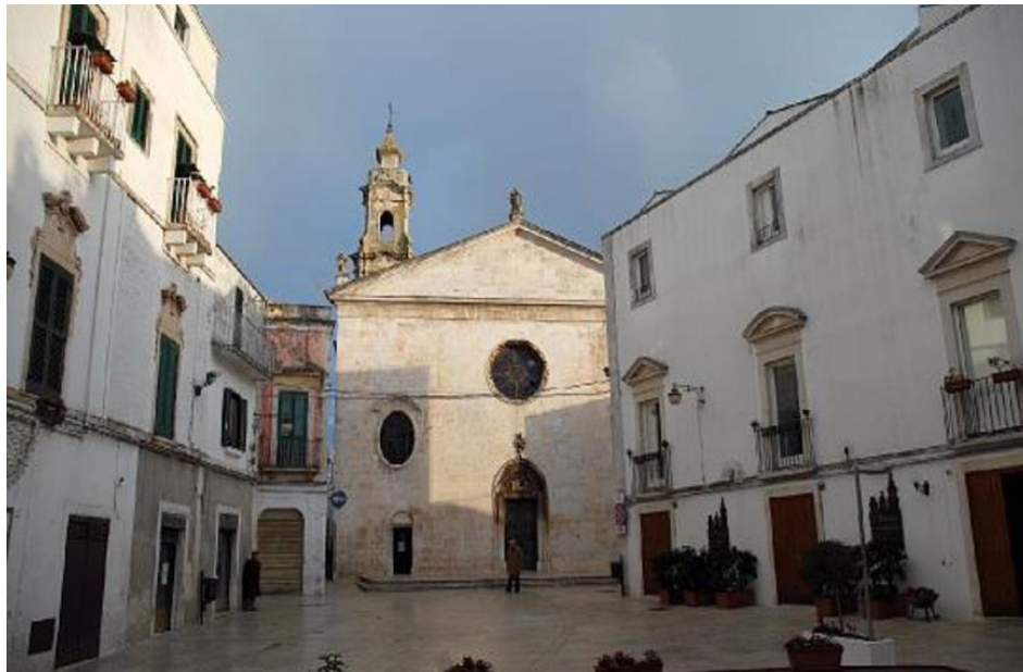
Figure 1 Church of “Santa Maria della Natività”, Noci (Bari, Italy).
