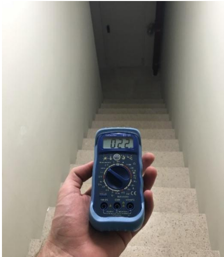
a-) Emergency stairs 220Lux
