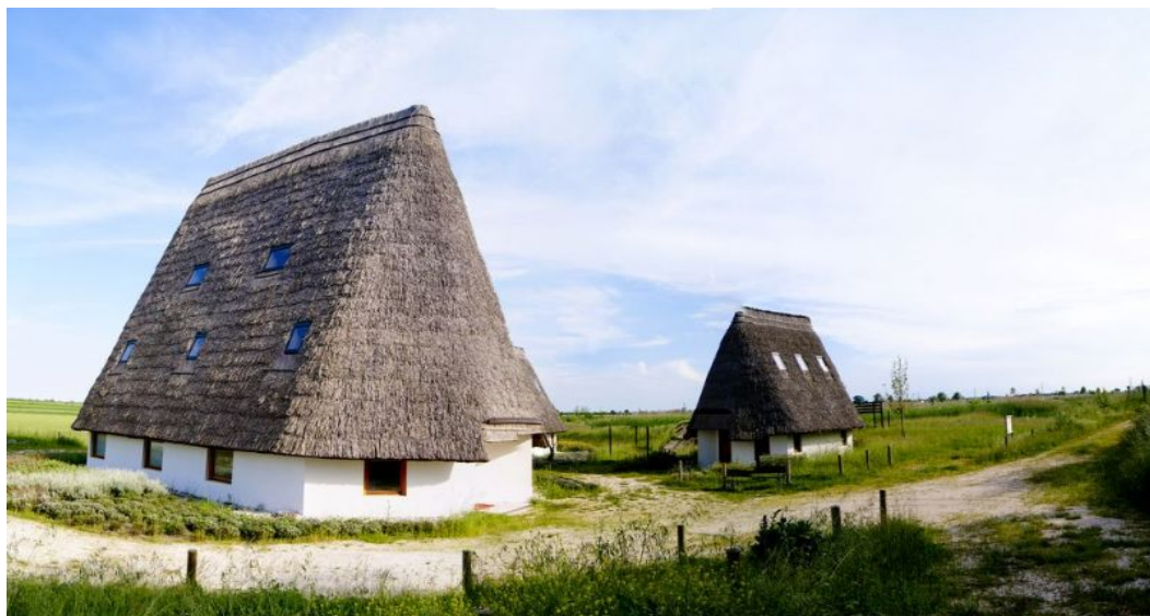
Figure 22. Casoni della Fogolana - courtesy of Municipality of Codevigo.
